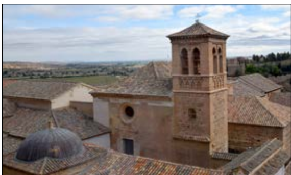
Schutzburg, Blick auf die Dachlandschaft
