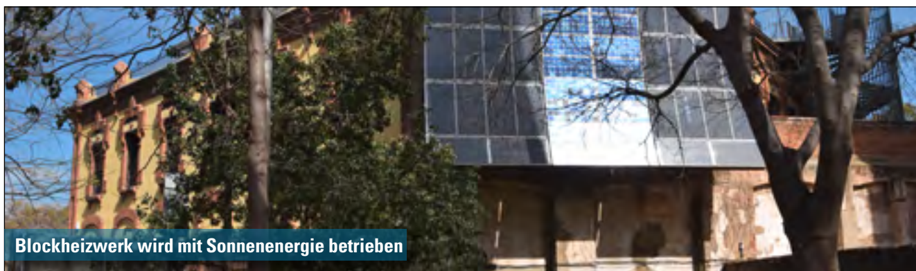
Wasserturm und alter Speicher
